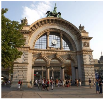
Torbogen Bahnhof Luzern
